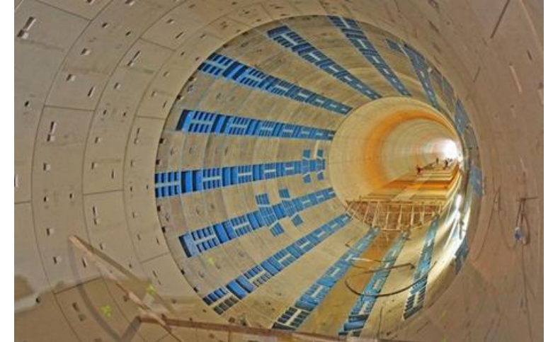
Quelle ZPP INGENIEURE AG
