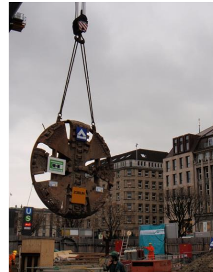
Quelle ZPP INGENIEURE AG
