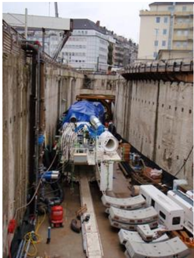
Quelle ZPP INGENIEURE AG
