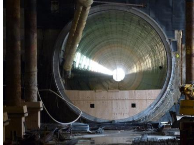
Quelle ZPP INGENIEURE AG
